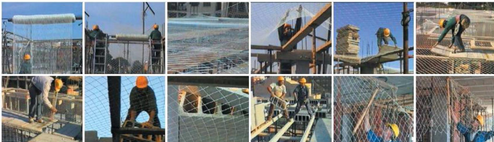
Secuencia de la instalación de una RED DE FORJADO DE USO ÚNICO.
