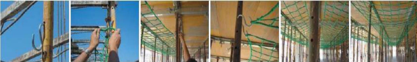
Secuencia de la instalación de una RED DE FORJADO REUTILIZABLE. / Secuencia de la instalación de una RED DE FORJADO REUTILIZABLE.
